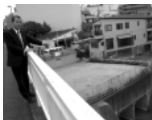
▲雨水管の出口と野川の現場で
