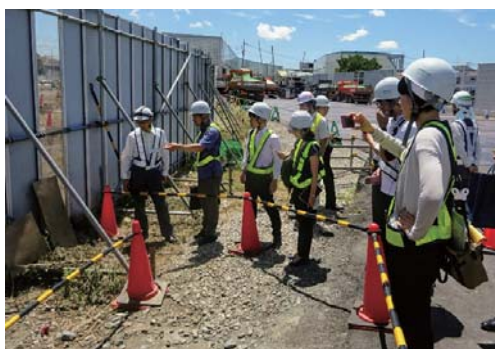
7/10 地下水流出現場を調査。左隅が地下水が出た場所。
